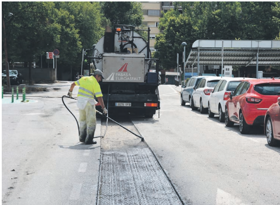
La primera intervenció s'ha realitzat a l'aparcament del Rubí Forma, on s'han reparat les parts més deteriorades. / Ajuntament
