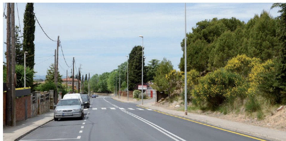
Els treballs s'executaran a les voreres de l'avinguda Castellbisbal. / Localpres-Ajuntament
