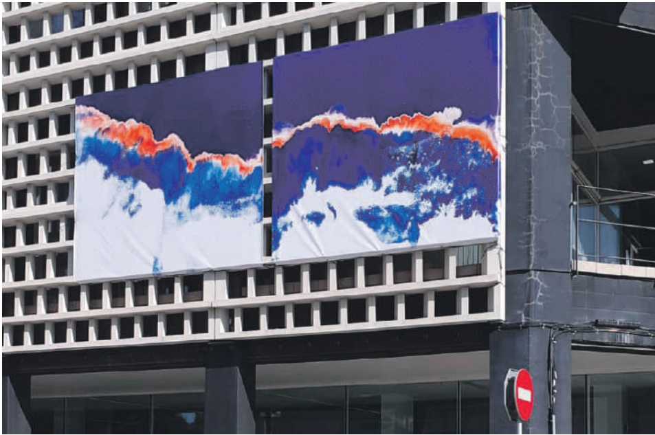
Diversos edificis tornaran a lluir fotografies de grans dimensions. / Arxiu
