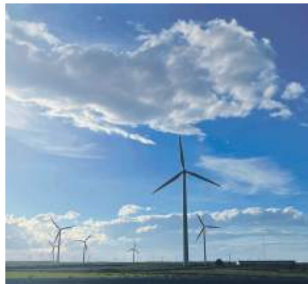
Els tres projectes d'alta tensió pretenen transportar energia dels parcs eòlics de l'Aragó fins a les subestacions de Rubí. / M.C.
