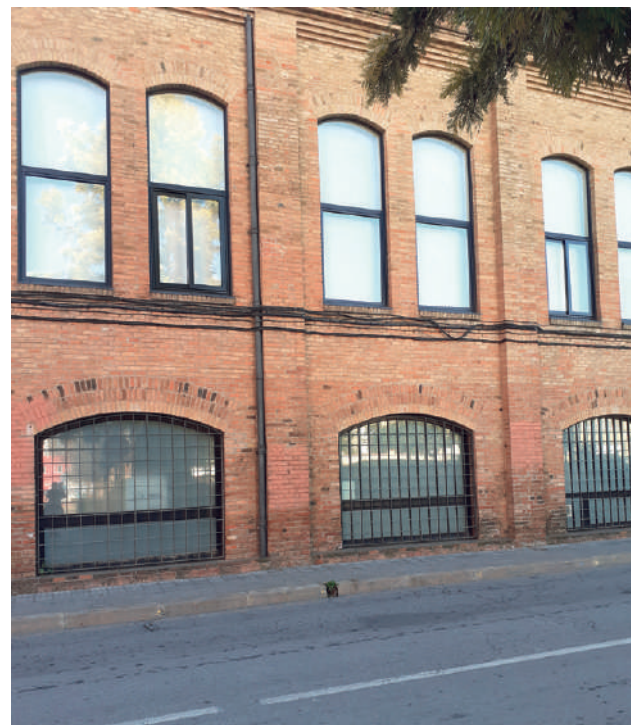
El refugi, que es troba tapat, s'ha localitzat a la sisena arcada de la façana posterior de l'edifici d'El Bullidor. C. BUXÓ
