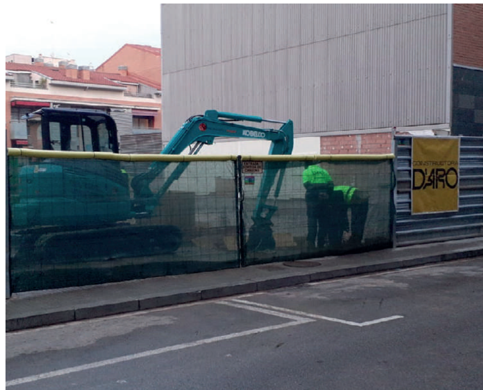
Les obres dels nous pisos han començat recentment. C.B.
