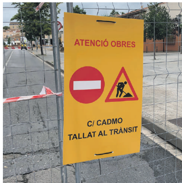
Obres al carrer Cadmo. A. BERNAVEU
