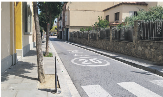
En aquest tram del c. Sant Sebastià s'igualarà la calçada al mateix nivell que el de les voreres. AJUNTAMENT
