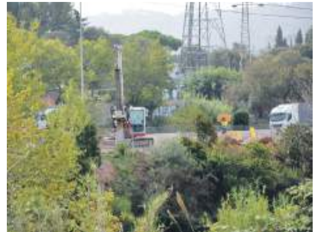
Imatge de les obres. AJUNTAMENT DE RUBÍ
