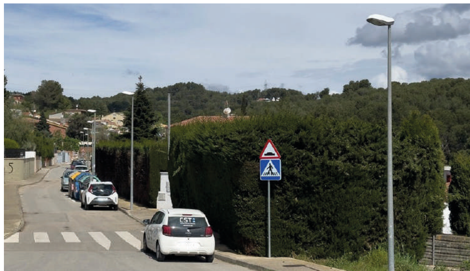
Aquesta zona a tocar del c. Sant Esteve i del camí d'Ullastrell ara disposa d'il·luminació. AJUNTAMENT-LOCALPRES
