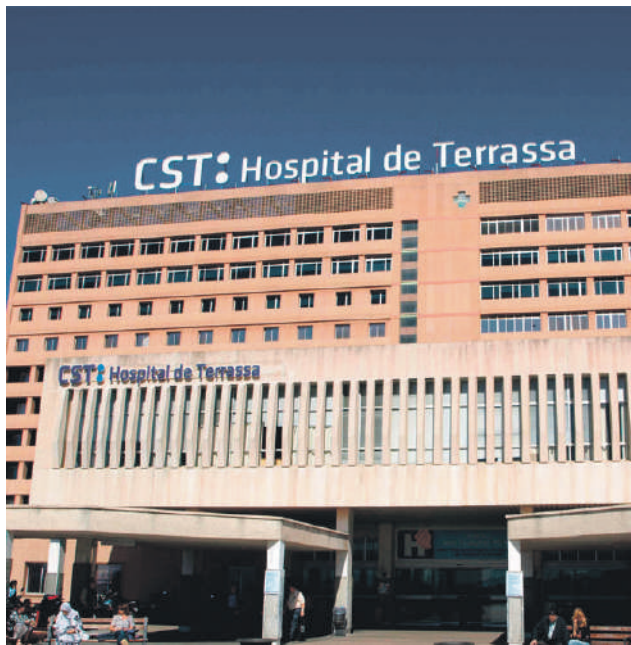
La façana de l'Hospital de Terrassa. CST
