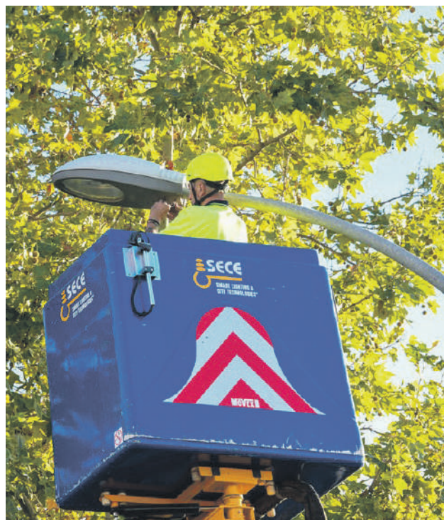
Canvi de lluminàries a la carretera de Terrassa. AJUNTAMENT-LOCALPRESS
